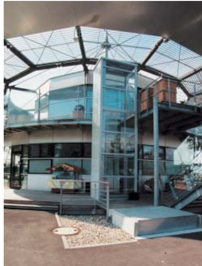
Zugang über die Terrasse
