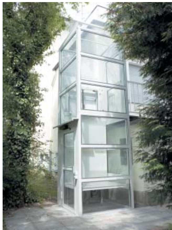
Lift mit Schacht aus Sicherheitsglas und Kunststoff
