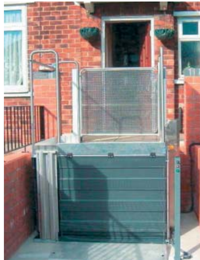
Moderne Türausfachung aus Edelstahllochblech
