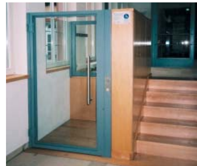
Lift mit großer Glastür, neben der Treppe eingebaut
