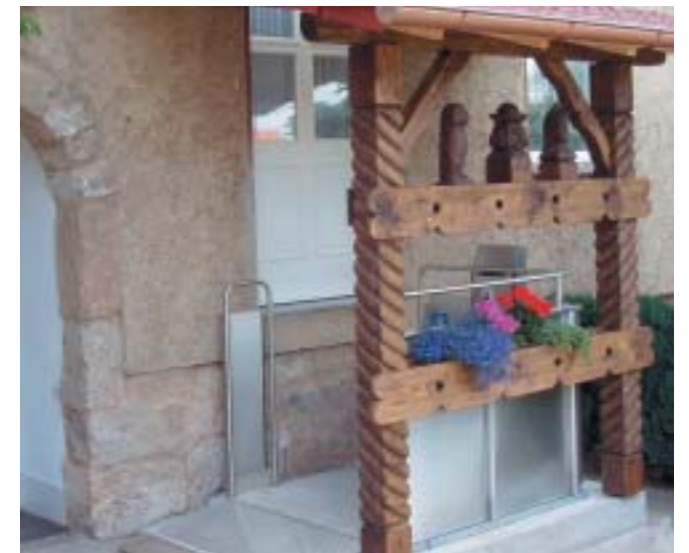
Überecklift mit bauseitiger Tür oben
