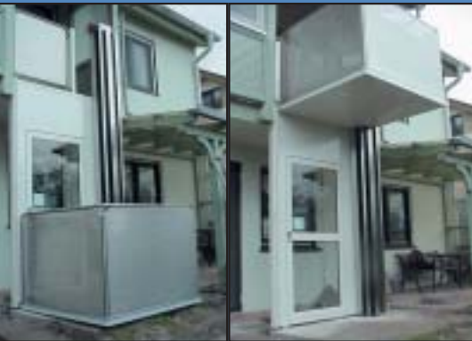
Anbau an Balkon mit zusätzlicher Schachtwand
