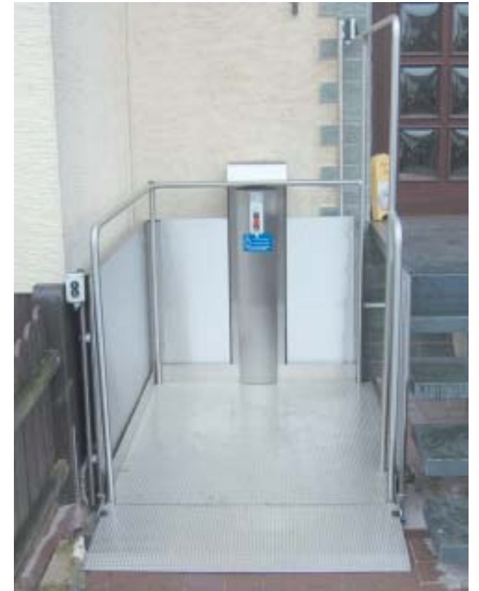
Überecklift mit mitfahrendem Sicherungsgeländer
